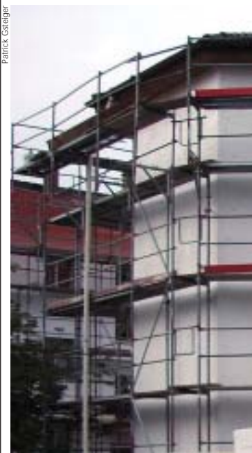
L'assainissement thermique d'une façade permet d'importantes économies d'énergie.
